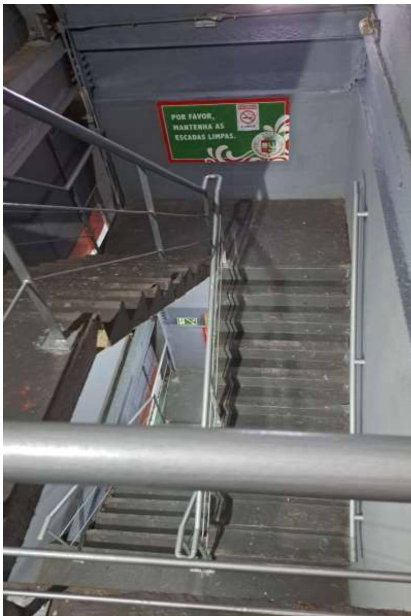
Figura 09 - Escadas de Acesso aos Andares
