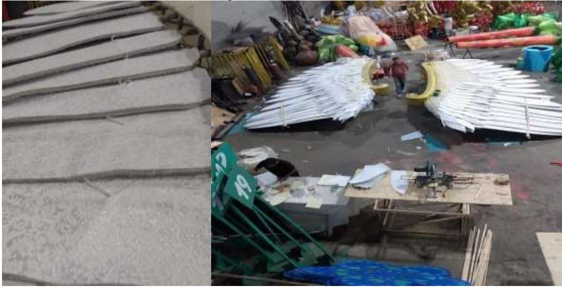
Figuras 91 e 92 – Equipe de Parintins Construindo o Mecanismo para que as Asas se Abram na Avenida, adereçando com Penas de Tecido (Dir.)
