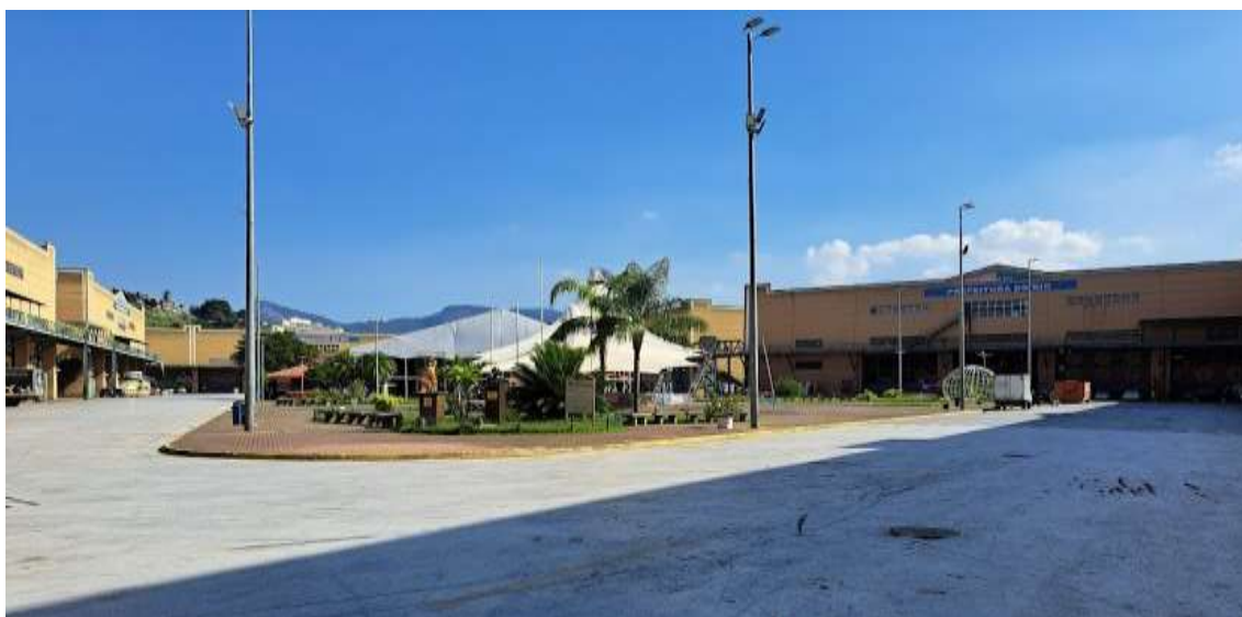
Figura 49 - Parte dos Galpões e Praça de Eventos 28
