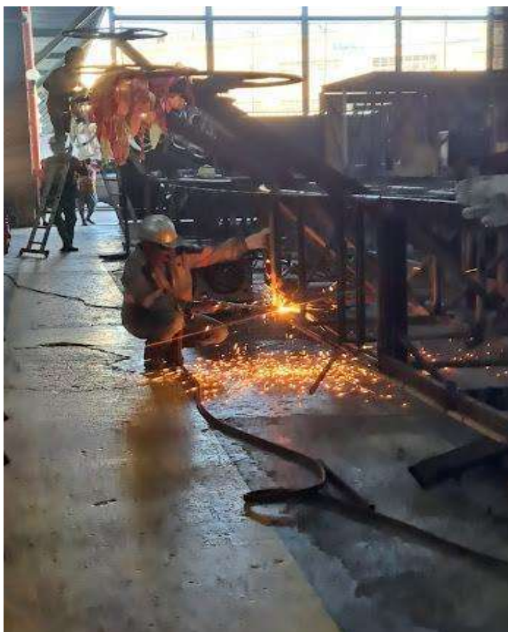
Figura 140 – Soldando Estruturas de ferro
