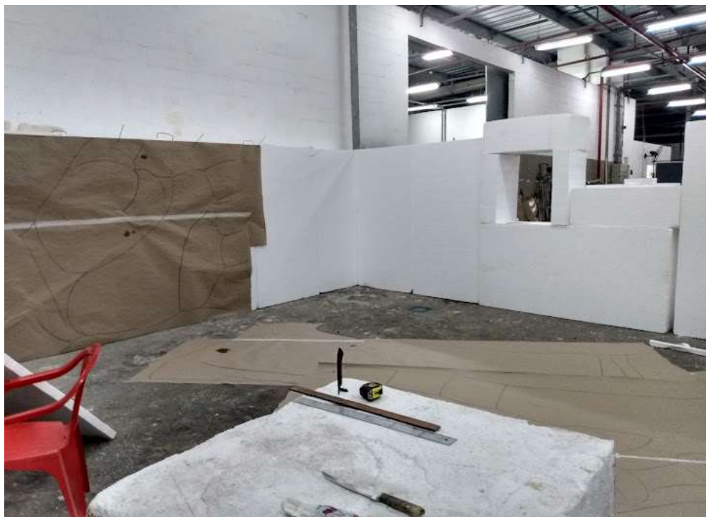
Figura 14 - Muros de Blocos de Isopor para Separar o Ambiente de Trabalho
