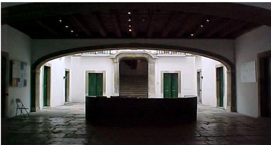
**Fig. 83** - Detalhe do interior do Paço Imperial que mostra um arco abatido vencendo um grande vão. Construção de Alpoim considerada inovadora para 1743. Foto do acervo de Milton Teixeira.
