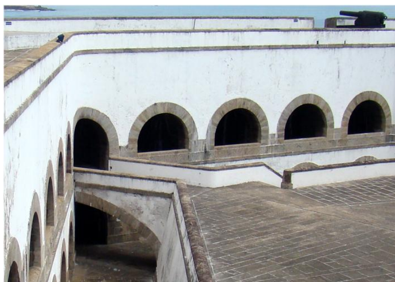
Capítulo 8 – Figura 188 – Arcadas e passadiço botaréu, Fortaleza de Santa Cruz, R. J.
