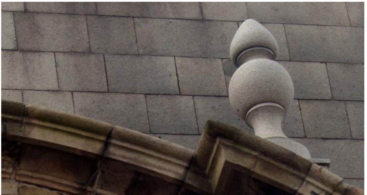
Capítulo 2 – Figura 49: Assentamento irregular à soga e tição, Puerta de La Ciudadela, Montevideo, Uy.
