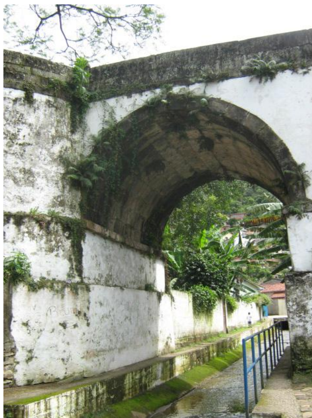
Introdução - Figura 19: Arco sobre estribos - Ponte de Marília Ouro Preto, M.G. (foto do autor).
