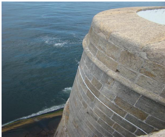
Capítulo 5 - Figura 84: Efeito informatizado ilustrativo - Muro com talude variável (foto e efeito do autor)
