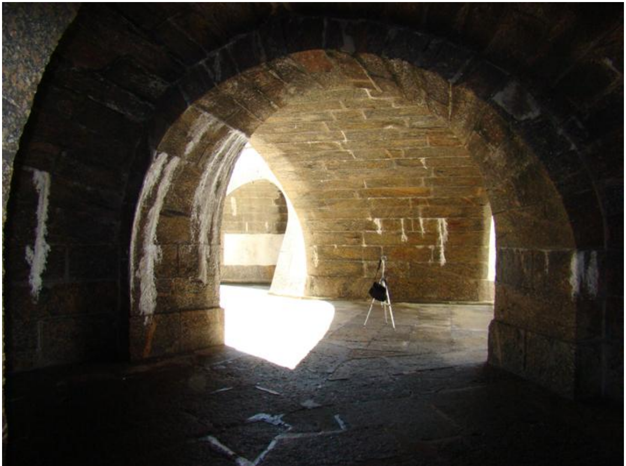
Capítulo 8 – Figura 194: Interseção da Abóbada de Arestas com o botaréu, arco aviajado ao fundo.
