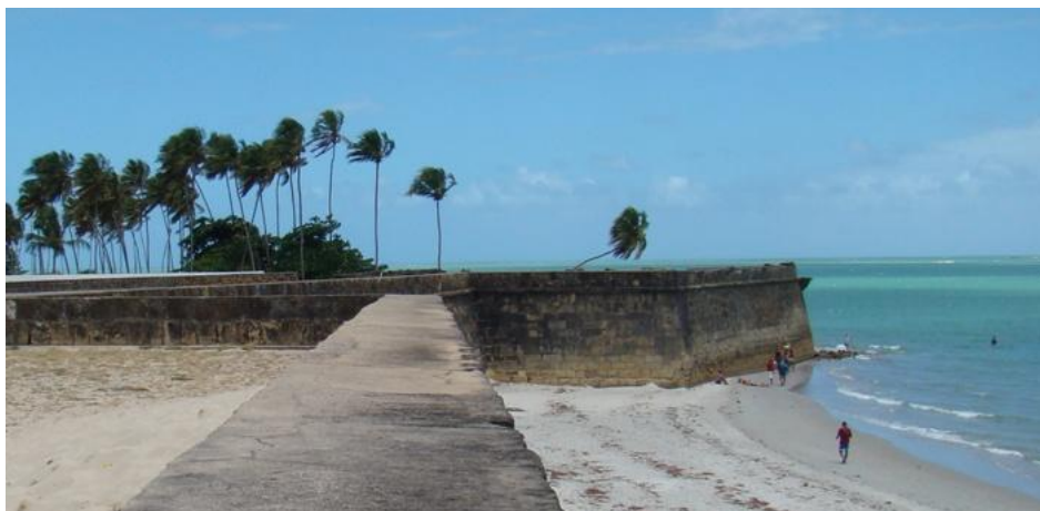
Capítulo 2 – Figura 40: Muro em Talude - Forte Orange em Igarassú, PE. (foto do autor).
