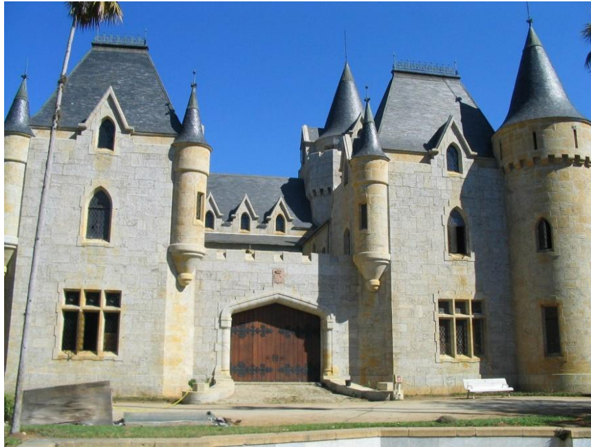
Capítulo 5 – Figura 79: Contra-exemplo: paramentos sem concordância no Castelo de Itaipava, R.J. (foto do autor).
