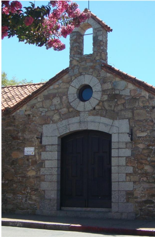
Capítulo 7 – Figura 148 e 149: Espectaculares dinteis fracionados em 7 e em 17 partes; a foto 148 é o Cuartel de Dragones de Maldonado e a foto 149 Santíssima Trinidad, Py (fotos do autor).
