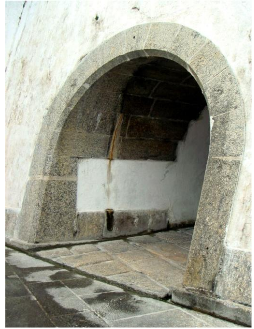
Capítulo 4 – Figuras 75 e 76: Cortina com chanfro em grande escala, Forte Monte Serrat, Salvador, Ba. Detalhe de chanfro em pequena escala, nas aduelas, um refinamento na Fortaleza de Santa Cruz, R.J. (fotos de Mário Oliveira e do autor).
