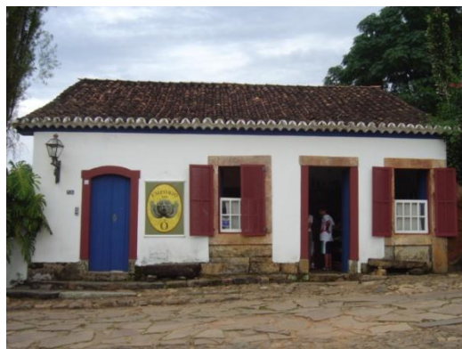
Introdução - Figura 9: Ombreiras de madeira e de pedra, Tiradentes, M.G. (foto do autor).
