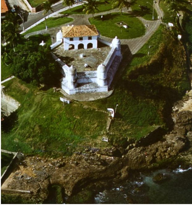
Capítulo 4 – Figuras 75 e 76: Cortina com chanfro em grande escala, Forte Monte Serrat, Salvador, Ba. Detalhe de chanfro em pequena escala, nas aduelas, um refinamento na Fortaleza de Santa Cruz, R.J. (fotos de Mário Oliveira e do autor).
