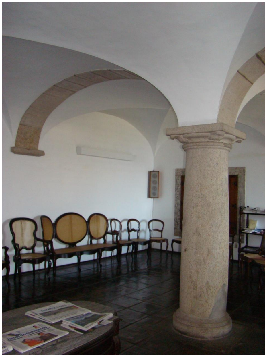
Capítulo 8 – Figura 176: Abóbadas de Arestas Abatidas – Mosteiro de São Bento, R. J. (foto do autor).
