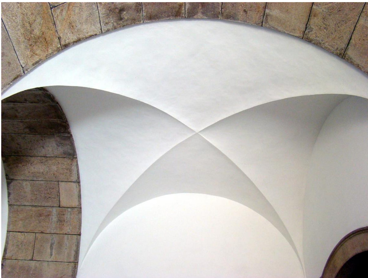
Capítulo 8 – Figura 173: Abóbada de Aresta, Claustro do Mosteiro de São Bento, Rio de Janeiro R.J. (foto do autor)
