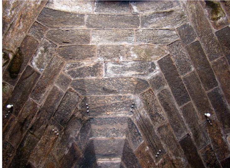
Capítulo 8 – Figura 192: Abóbada de arestas Superior Fortaleza de Santa Cruz, R.J. (foto do autor)
