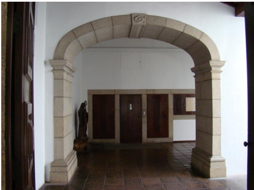
Capítulo 6 – Figura 109A: Arco Abatido, Mosteiro de São Bento do Rio de Janeiro (foto do autor).
