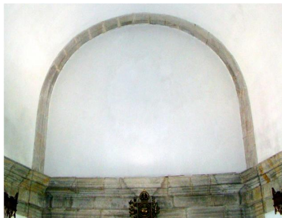
Capítulo 6 – Figuras 103 e 103A: Arco alteado. Capela de N. Sra. da Glória do Outeiro, R.J.
