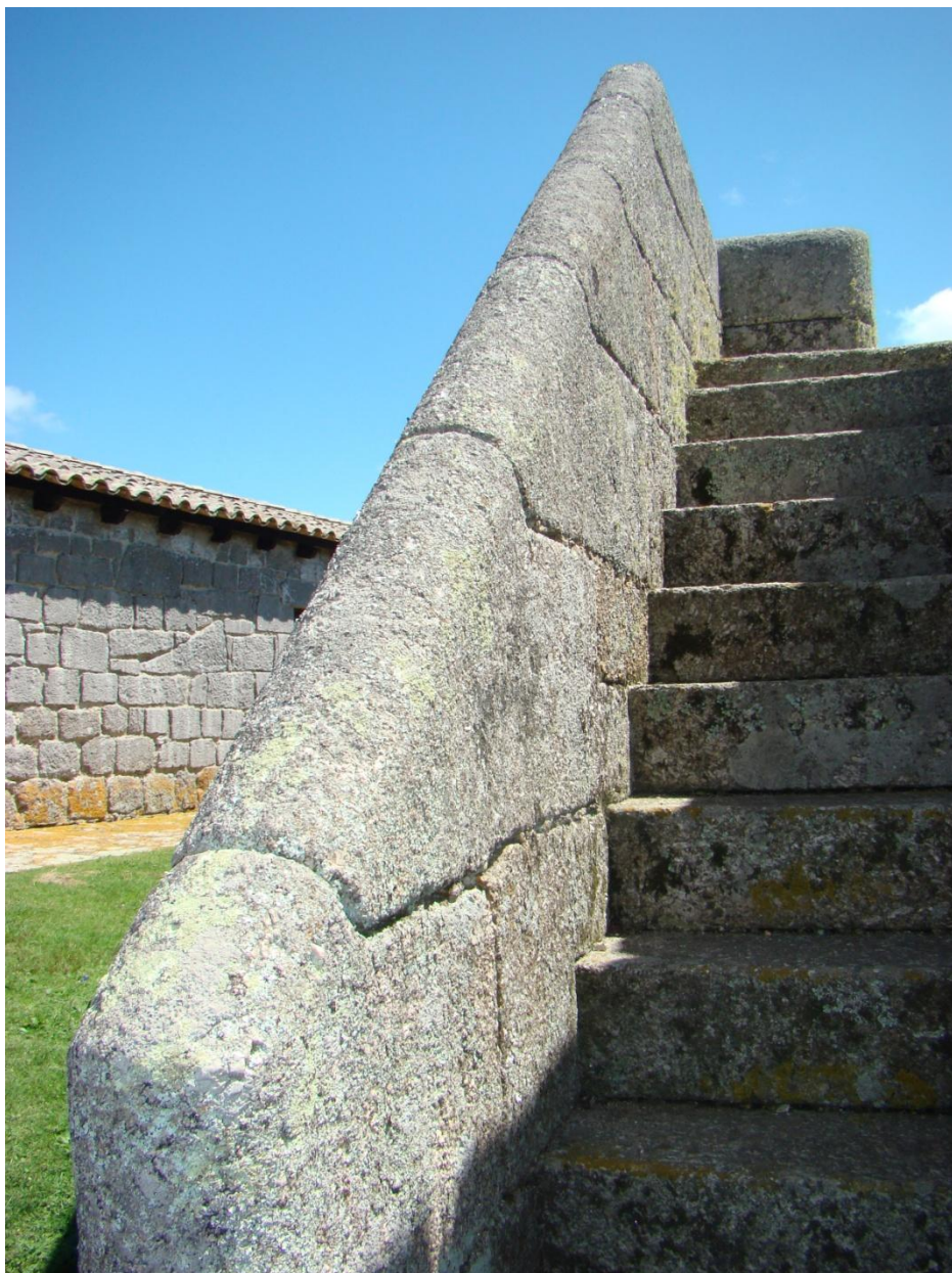
Capítulo 2 – Figura 54: “Distância segura” no guarda corpo, Fortaleza de Santa Teresa, Uy.
