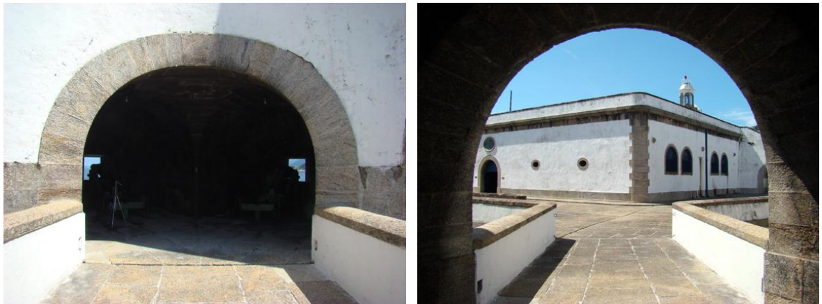
Capítulo 8 – Figuras 186 e 187: Arcada maior de acesso do pátio. Fortaleza de Santa Cruz, R. J. (fotos do autor)
