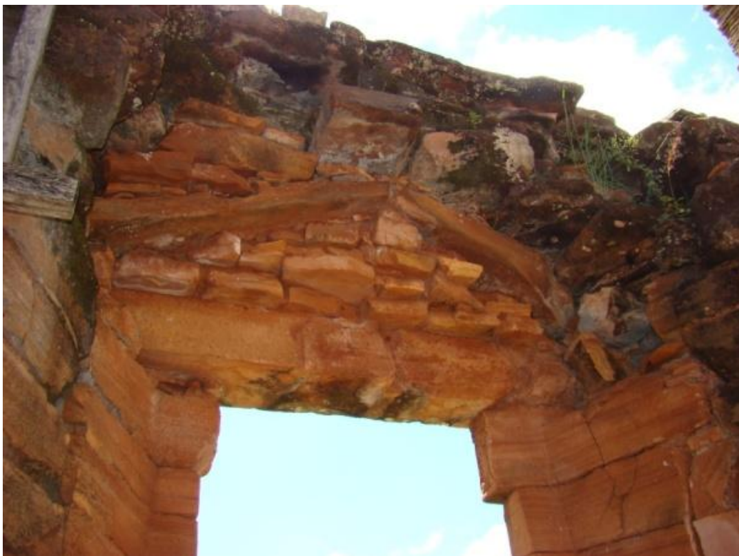
Introdução - Figura 11: Arco projetado transverso - Missão de San Ignacio Mini, Ar. (foto do autor).
