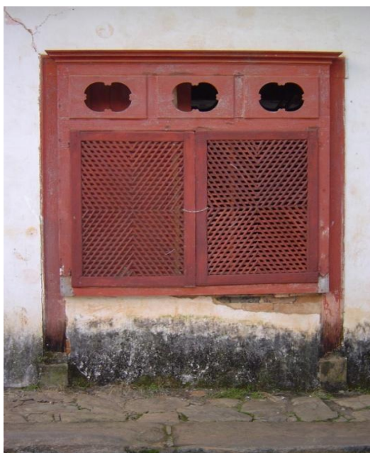
Capítulo 6 – Figura 90: Gelosia aplicada sobre o vão (foto do autor).
