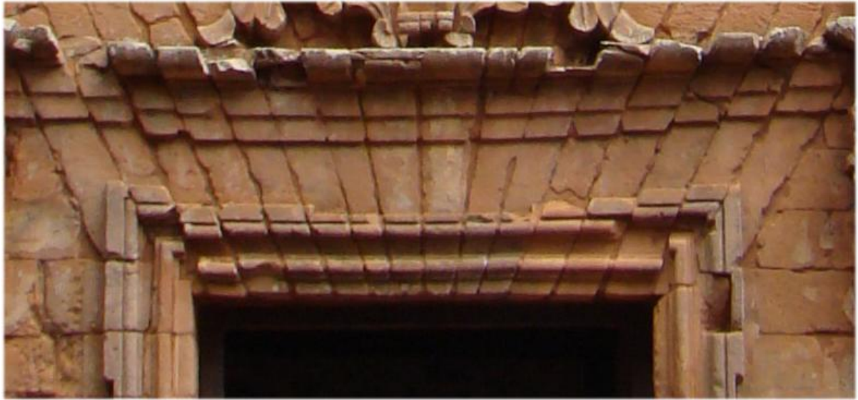
Capítulo 6 - Figura 133: Arco de Dintel Fracionado, Missão Jesuítica de Trinidad, Py. (foto do autor)
