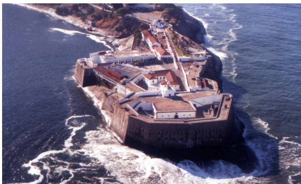
Capítulo 5 - Figura 83: Muros em Talude de inclinação constante, na Fortaleza de Santa Cruz, Niterói, R.J. (foto do autor-poster).
