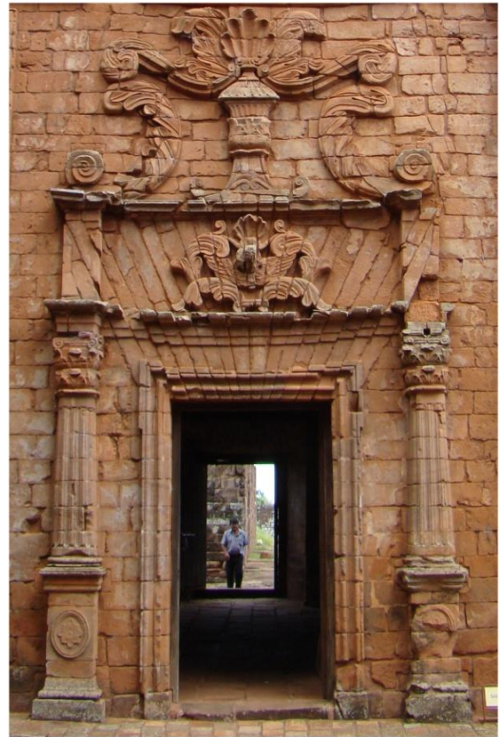
Capítulo 7 – Figura 148 e 149: Espectaculares dinteis fracionados em 7 e em 17 partes; a foto 148 é o Cuartel de Dragones de Maldonado e a foto 149 Santíssima Trinidad, Py (fotos do autor).
