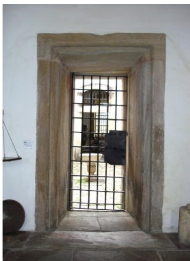
Capítulo 6 – Figura 91: Chanfro e derrama, Casa de Câmara e Cadeia de Ouro Preto, M.G (foto do autor).
