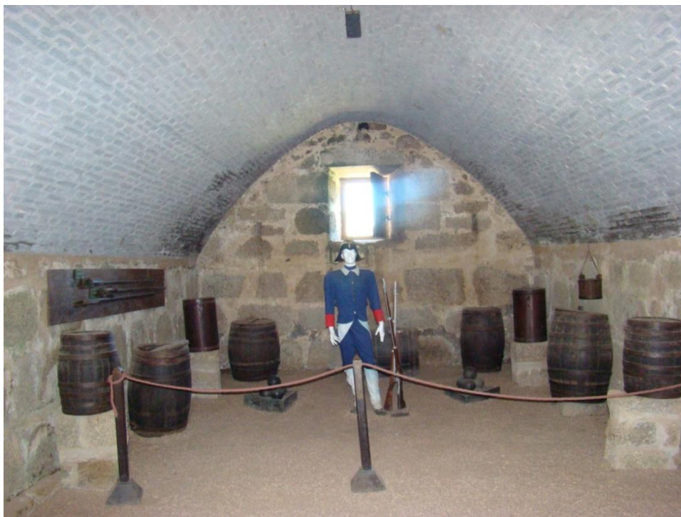
Capítulo 6 – Figura 108: Cúpula em berço hiperbólico, Fortaleza de Santa Teresa, Uy (foto do autor).
