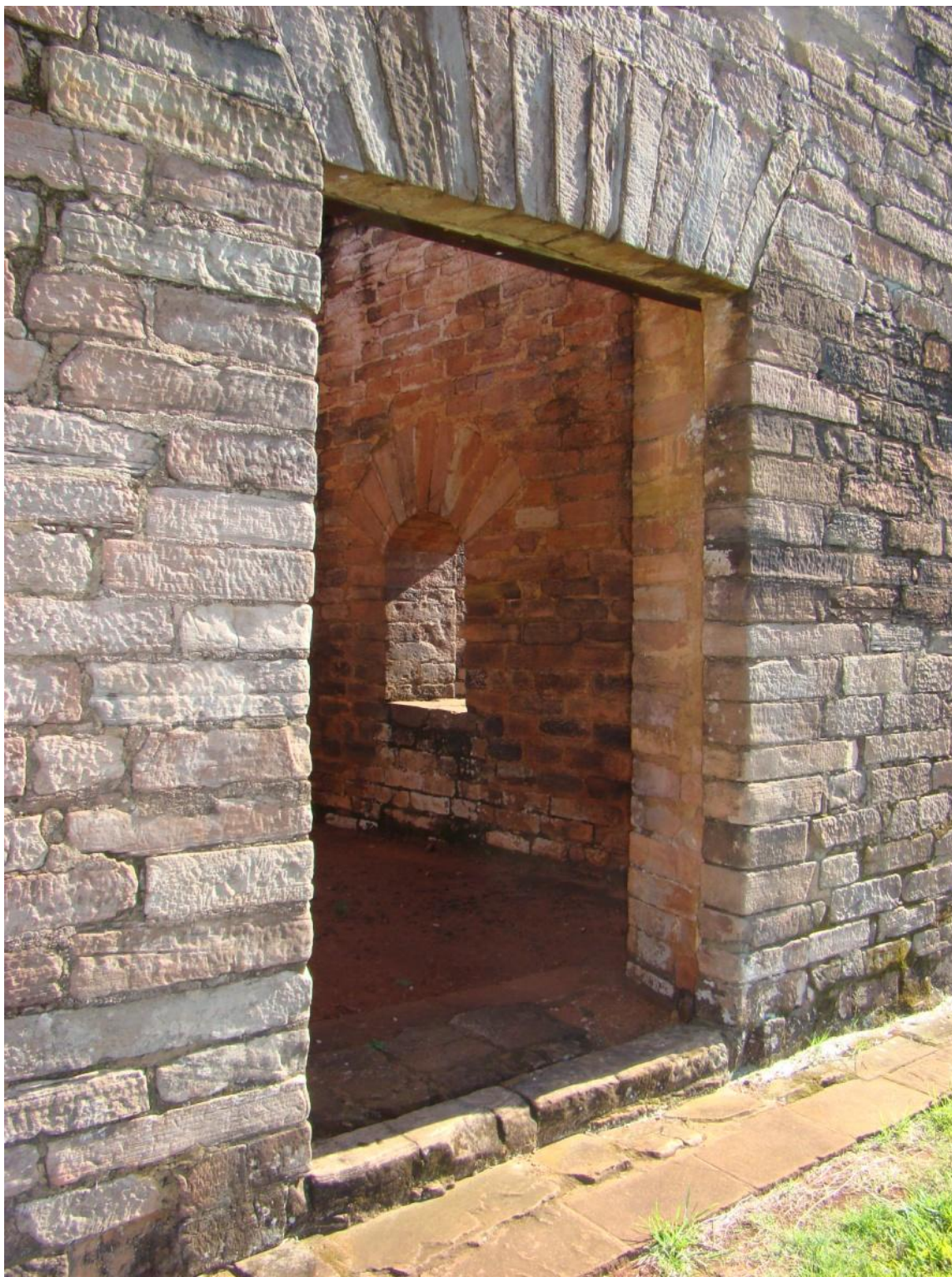
Capítulo 7 – Figura 140: Dintel decupado em 13 partes, Missão Jesuítica de Jesús Tavarengué, Py (foto do autor).
