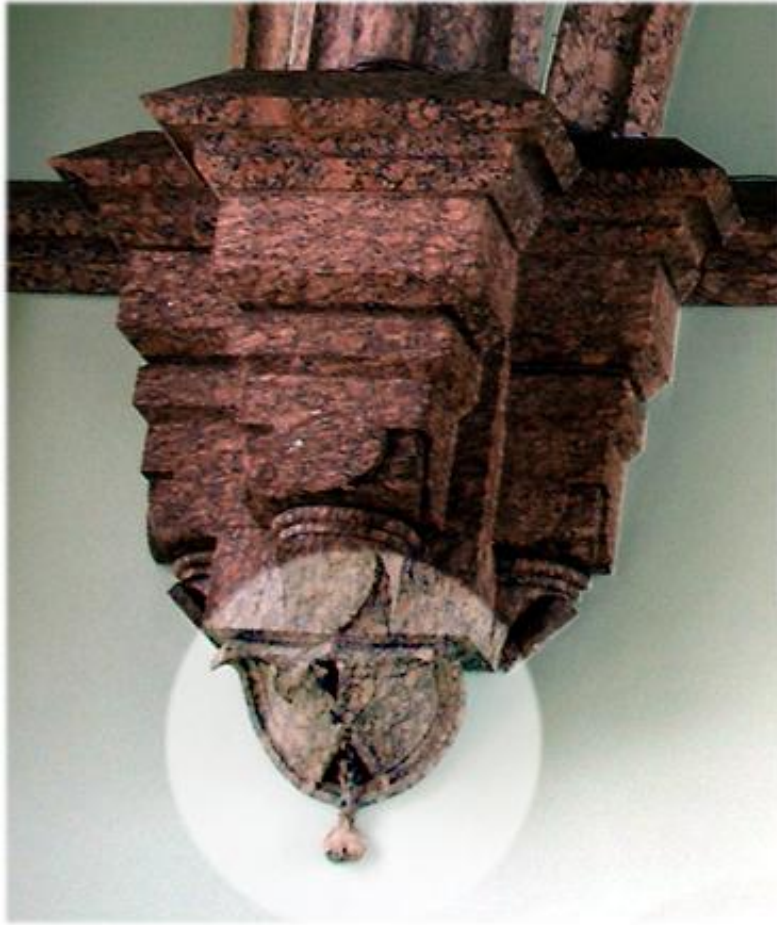
Capítulo 1 – Figura 33B: Assinatura de Canteiro (martelo e ponteira) – Ilha Fiscal, R.J.
