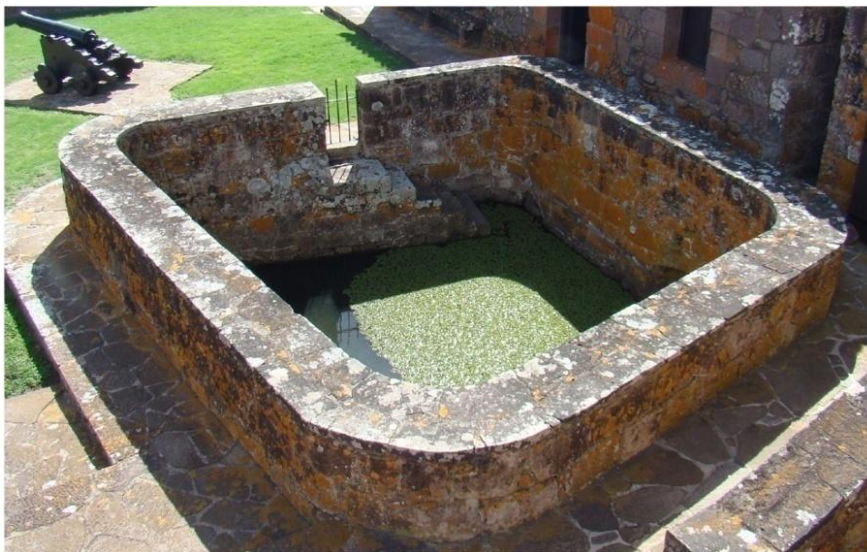
Capítulo 5 – Figura 78: Concordância de muros retos, de seção reta invariável, Forte de São Miguel, Uy.
