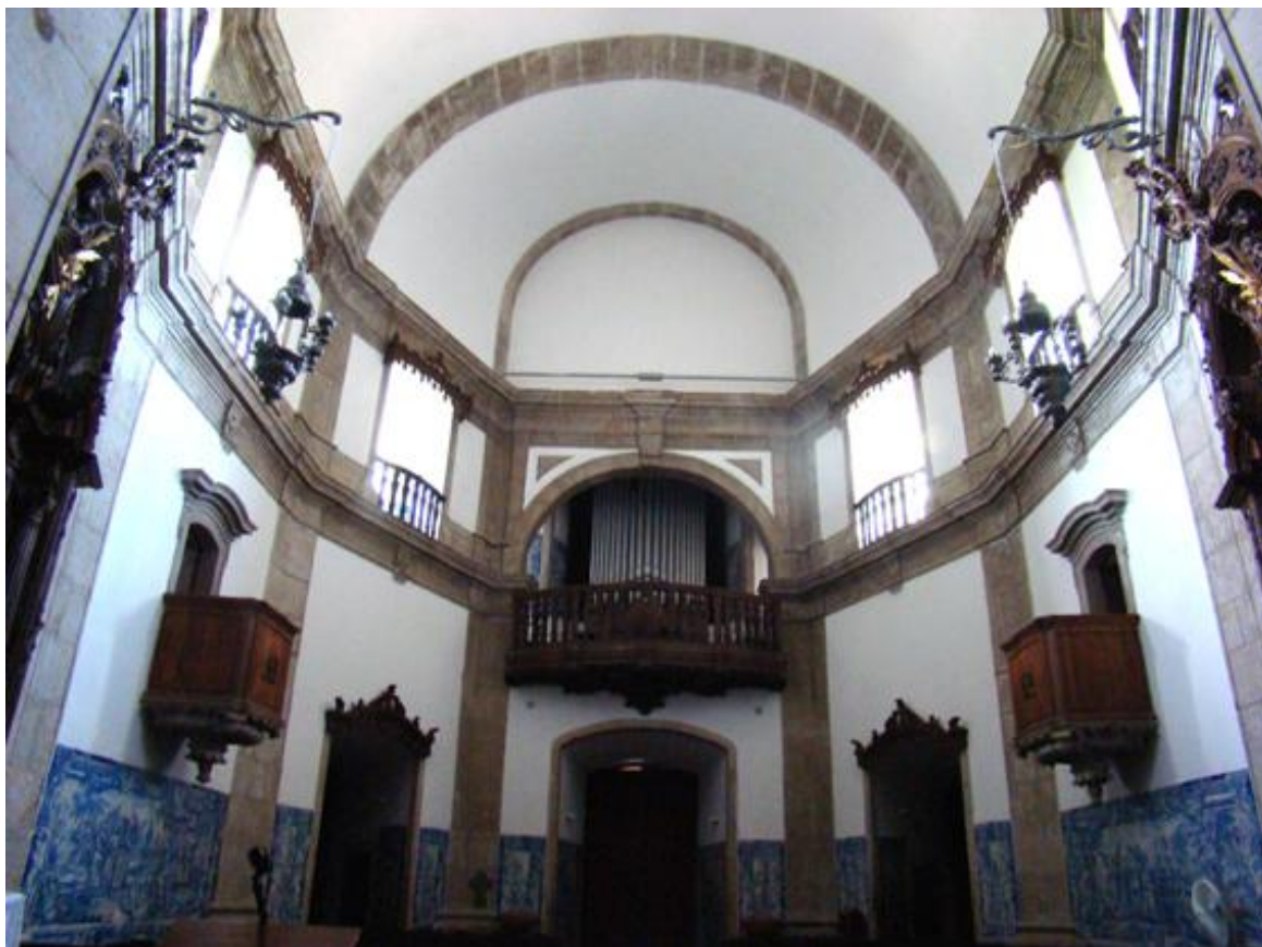
Capítulo 6 – Figura 98: Arcadas de quatro espécies distintas: Rebaixadas, Plenas, Alteadas e Abatidas; Capela de Nossa Senhora da Glória do Outeiro, R.J. (foto do autor).
