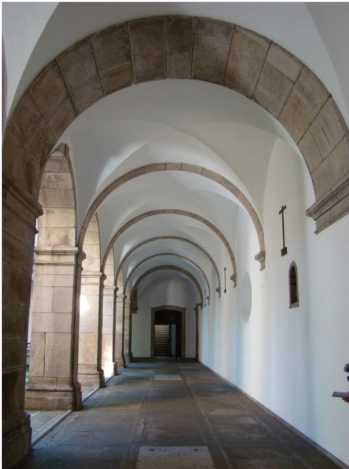
Capítulo 8 – Figura 183: Galeria de Abóbadas de Aresta do Claustro do Mosteiro de São Bento, R. J. (foto do autor).
