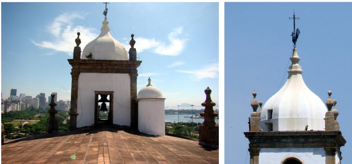
Capítulo 8 – Figuras 180 e 181: Aspecto externo em Barrete de Clérigo – Campanário da Capela de N. S. da Glória do Outeiro, R.J. (foto do autor).
