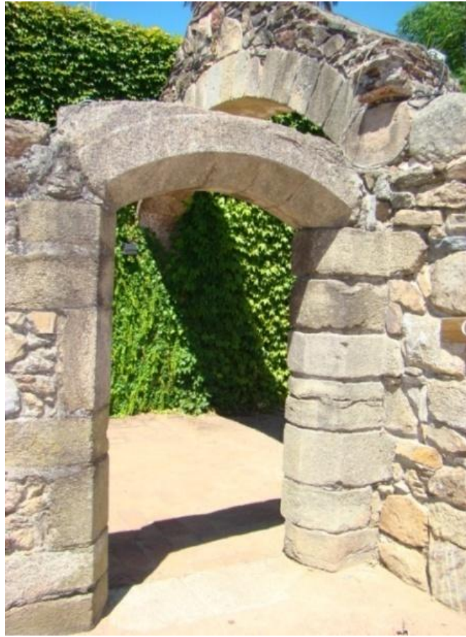
Capítulo 6 – Figura 94: Ombreiras segmentadas ou fracionadas, Cuartel de Dragones, Maldonado, Uy (foto do autor).
