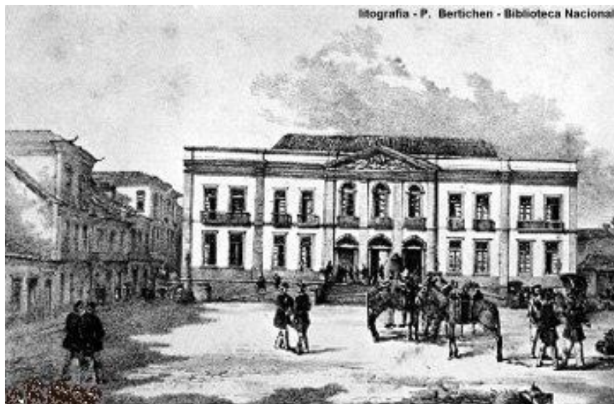
Figura25: Prédio da Escola no Largo de São Francisco (Rio de Janeiro).
