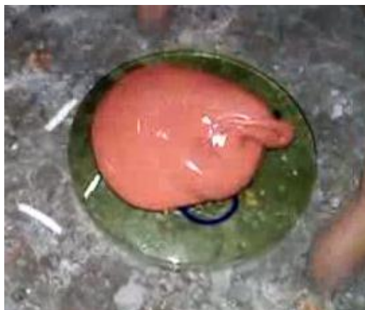
Figura 69 - Lacre sobre o bloco óptico. Fonte: Foto do autor.
