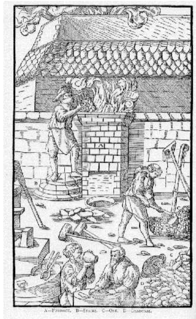
Figura II-15: A figura ilustra o mestre fundidor no topo de uma escada (B) carregando um alto-forno (A) com minério (C) e carvão (D). (Fonte: AGRÍCOLA, Georgius. De Re Metallica . Translated from the first Latin edition of 1556 by Herbert Clark Hoover and Lou Henry Hoover. New York: Dover Publications, 1950, p.424).
