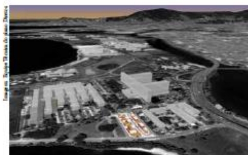
Vista geral da localização.
