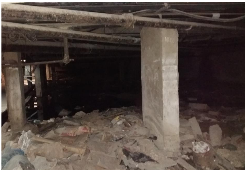
Figura 19: Os “porões” do bloco F do CT Fonte: do autor
