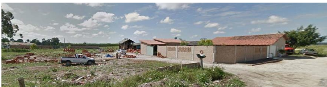
Figura 48 - Residência e Olaria de Fernando Araújo 46
