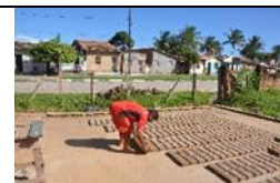
Figura 166 - Colocando os tijolos para secagem
