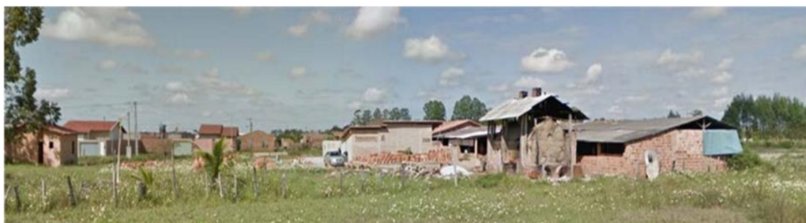
Figura 183 - Vista 2 - dos fundos da olaria
