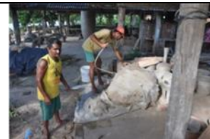
Figura 82 - Colaboradores socando o barro
