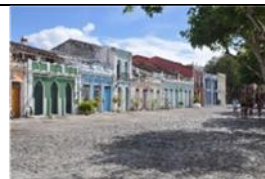
Figura 68 - Casario do Centro de Belmonte
