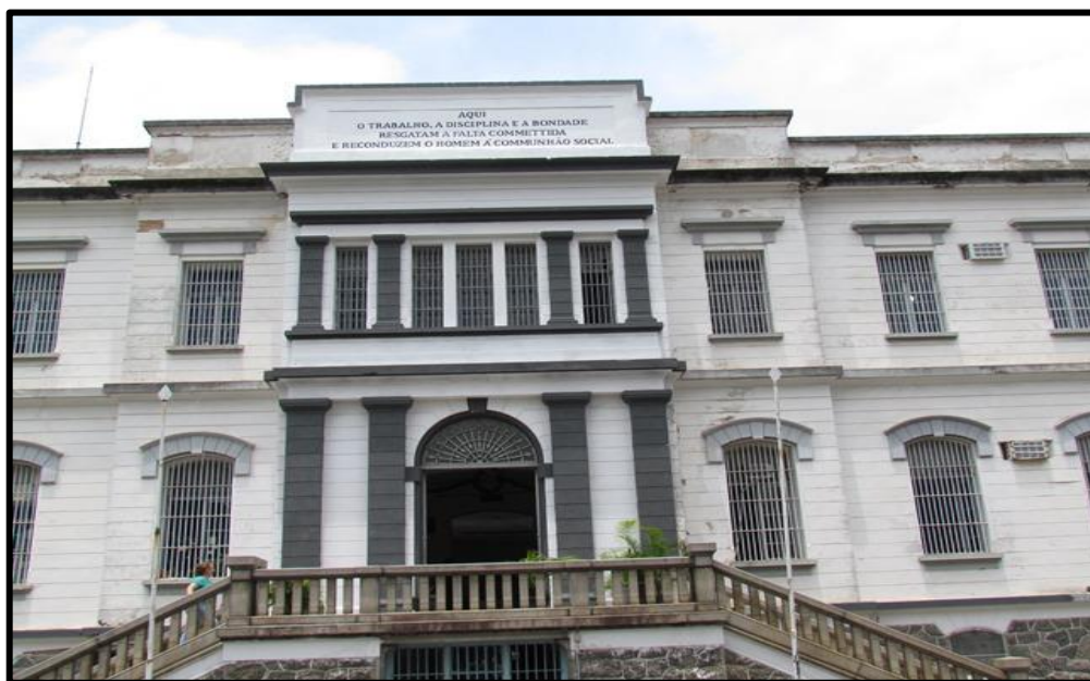
Figura 26 - Fachada do prédio da administração da Penitenciária atualmente
