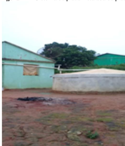
Figura 12 – Cisterna de placa instalada de placa
