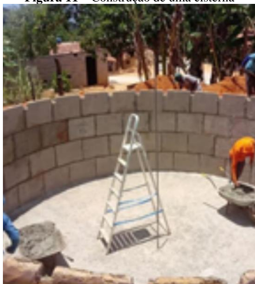
Figura 11 – Construção de uma cisterna
