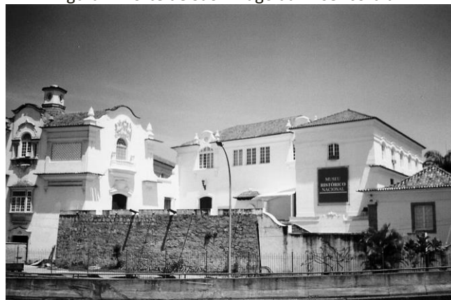
Figura1 - Forte de São Thiago da Misericórdia –
